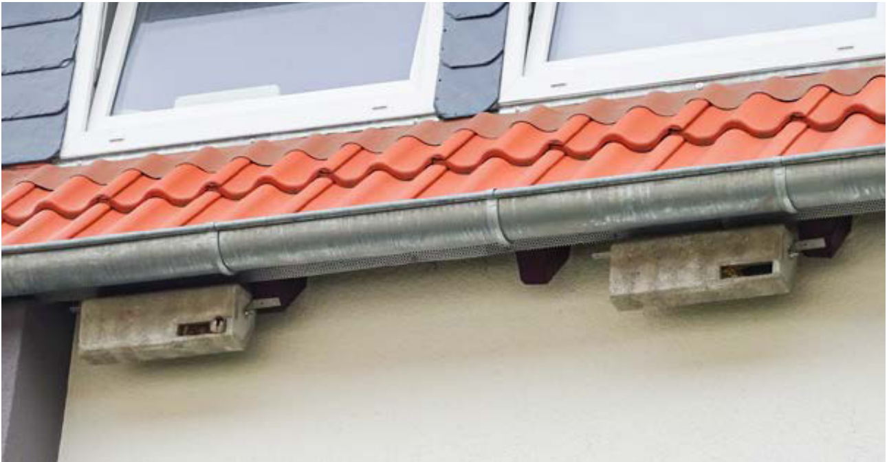
Ein im Handel zu beziehender Nistkasten mit jeweils einer Brutkammer für Mauersegler. Diese Kästen sind unterhalb der Dachrinne an den Dachsparren befestigt.
