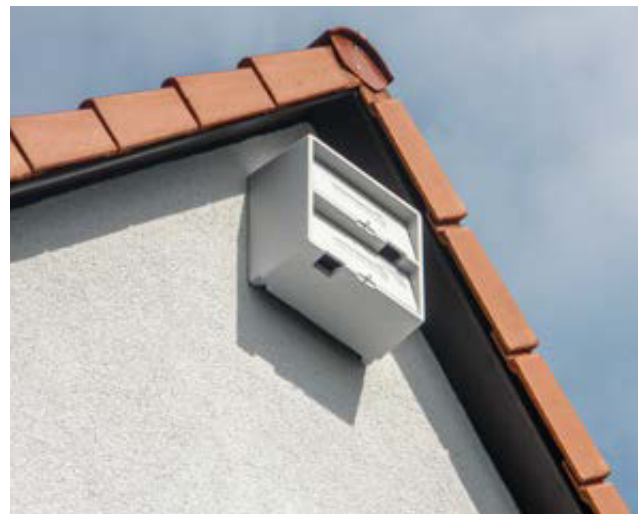
Ein im Handel zu beziehender Nistkasten mit zwei Brutkammern für Mauersegler, der auf die Fassade montiert wird. Die Rückwand ist nach innen versetzt und bietet so zusätzlich Fledermäusen ein Spaltenquartier zwischen Hauswand und Nistkasten.
