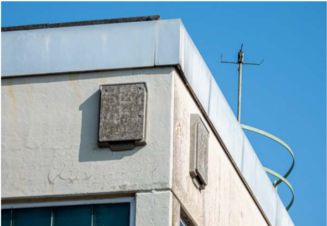
Fassadenkästen für Fledermäuse als vorgezogene Ausgleichsmaßnahme
