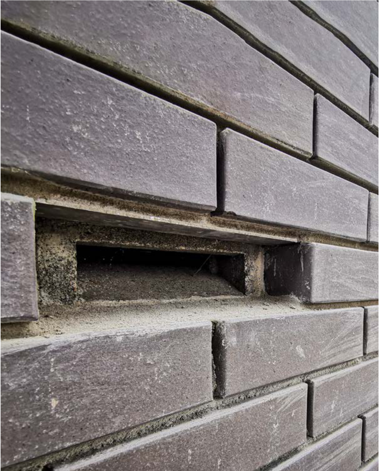
Nach Sanierung in Fassade eingelassene Fledermausquartiere
